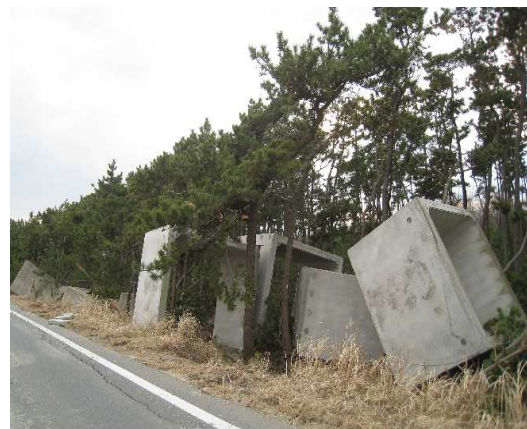
【 大地震により引き起こされた大津波による甚大な被害 】 小名浜港・新舞子浜
