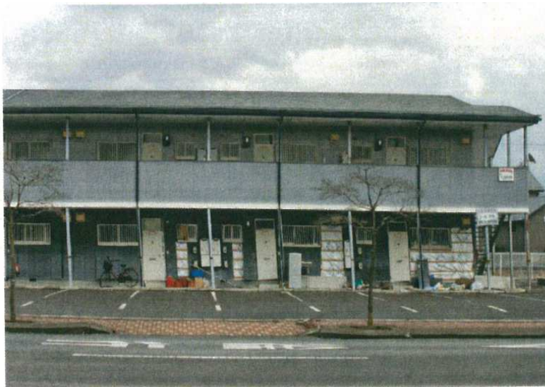
【 液状化による地盤変形とそれに伴う建物の傾斜 】
