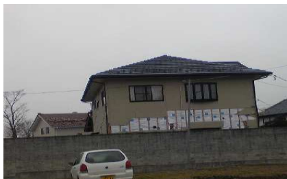
【 外壁破損家屋 】
