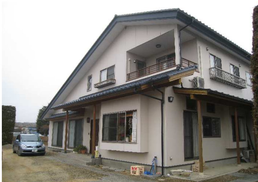
【 外観状況 】 コロンブス工法を採用
