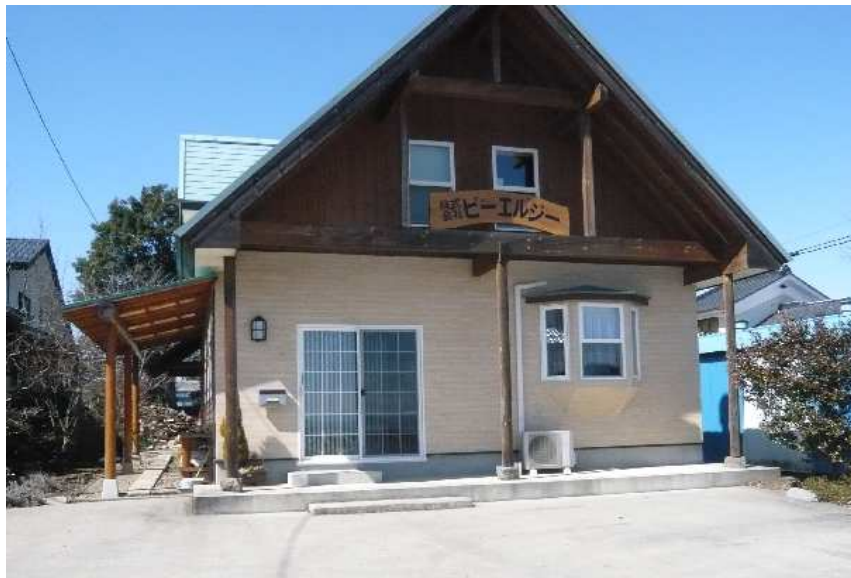
【 外観状況 】 コロンブス工法を採用
