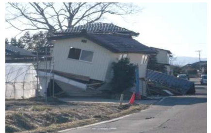
【 倒壊した家屋 】
