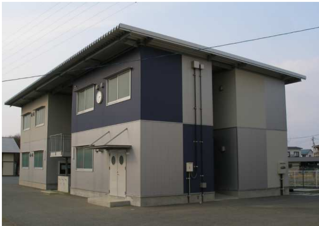
【 外観状況 】 コロンブス工法を採用
