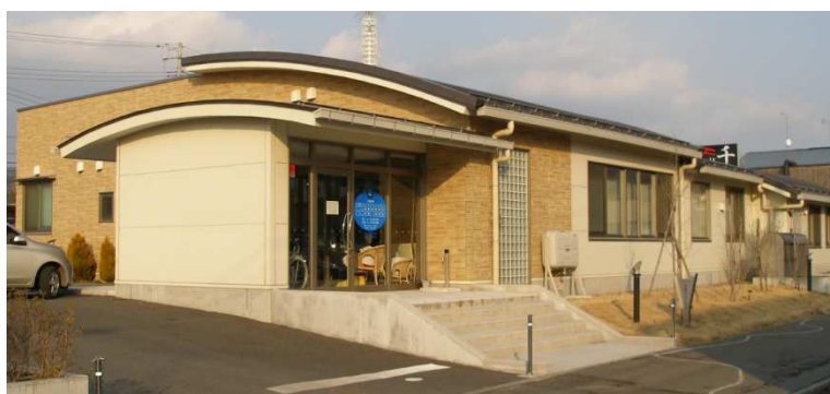
【 外観状況 】 コロンブス工法を採用
