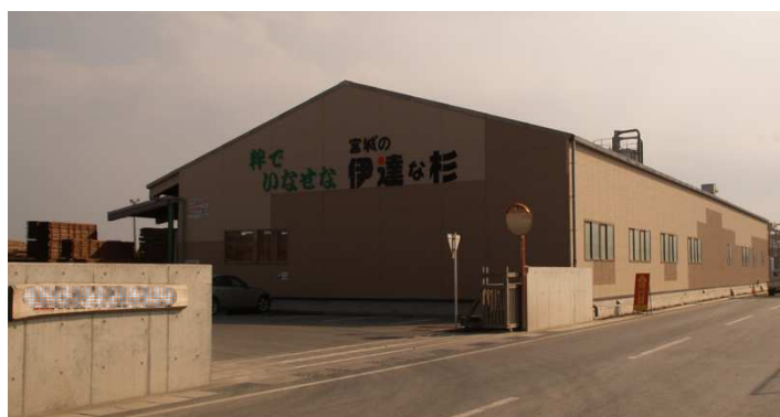
【 外観状況 】 コロンブス工法を採用
