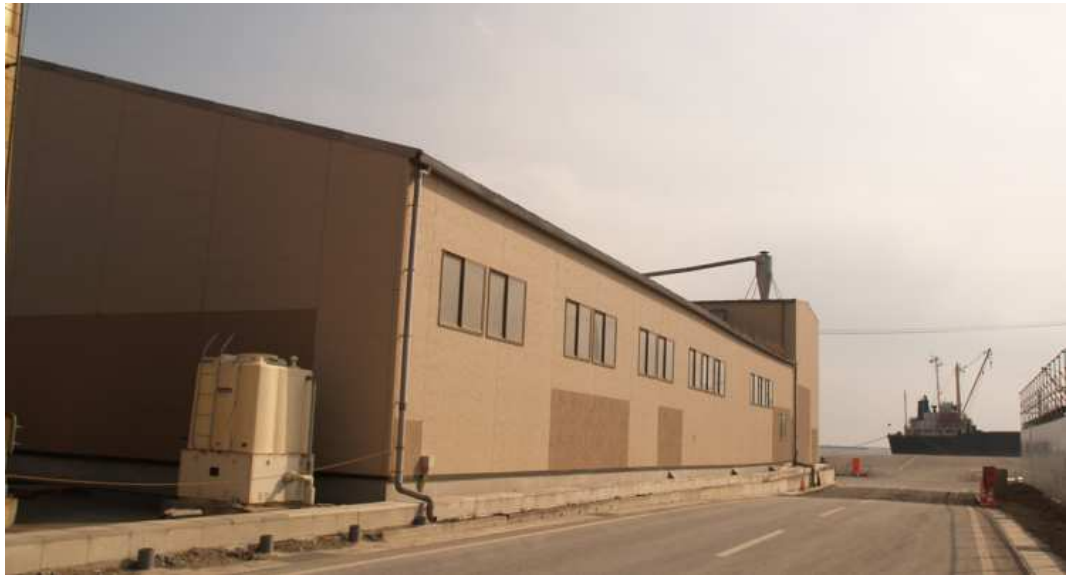
【 外観状況 】 コロンブス工法を採用
