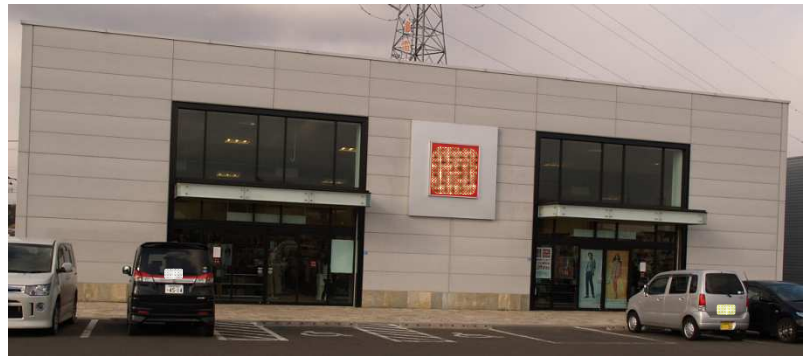
【 外観状況 】 コロンブス工法を採用
