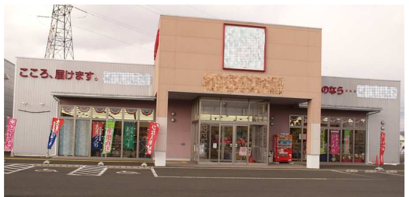
【 外観状況 】 コロンブス工法を採用
