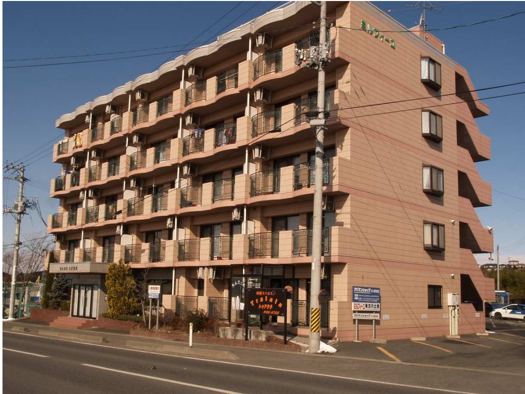
【 外観状況 】 コロンブス耐震杭工法を採用
