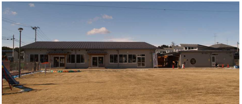
【 外観状況 】 コロンブス工法を採用
