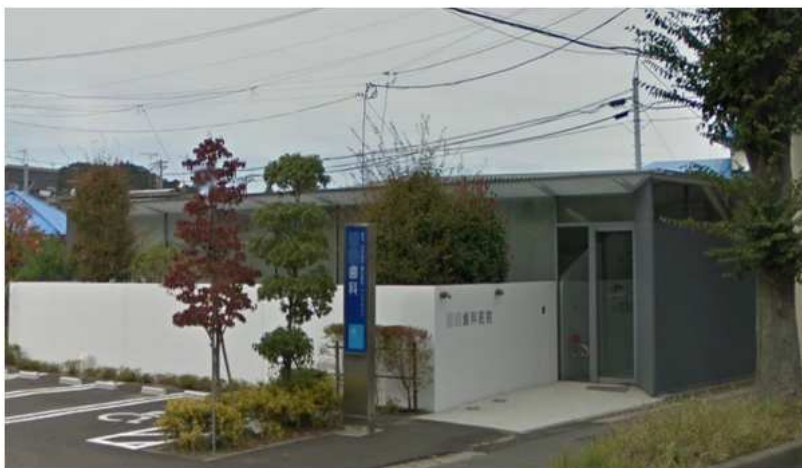
【 外観状況 】 コロンブス工法を採用
