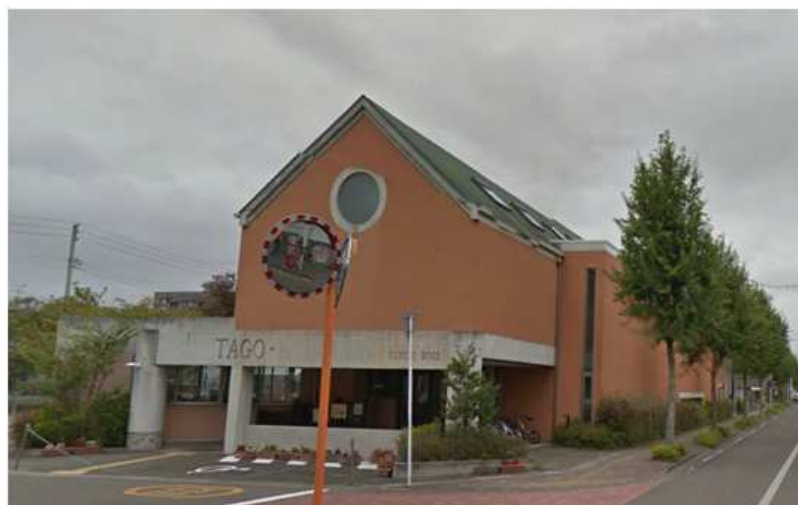
【 外観状況 】 コロンブス工法を採用
