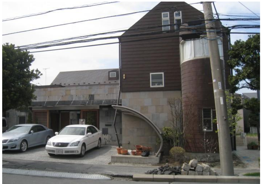
【 外観状況 】 コロンブス工法を採用
