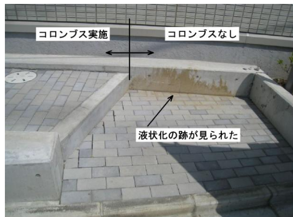
【 外観状況 】 外構にコロンプス工法を採用
