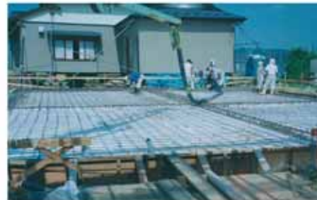
スラブ配筋・スラブコンクリート打ち
