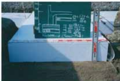
梁下ジオフォーム設置
