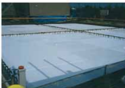
スラブ下ジオフォーム設置
