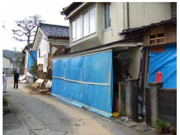
ピアサポート500m付近 川沿いの住宅土蔵の被害が大きい
